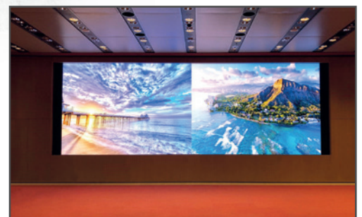
Beispielinstallation: Wand, Installation durch Dekom AG / Samsung IF-Serie
