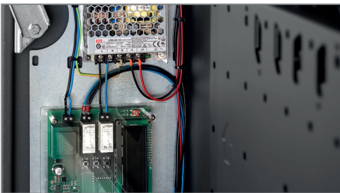
Verkabelung nach VDE-Richtlinien
